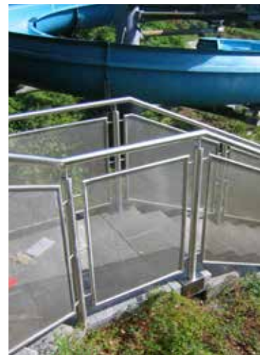
Abbildung 21: Treppenanlage aus nichtrostendem Stahl
